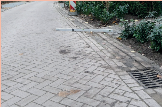
Afb. 18 v.l.n.r.: klik bij kolk en in gootlagen bij molgoot, verband straatbakstenen, meting verdichting zandbed
