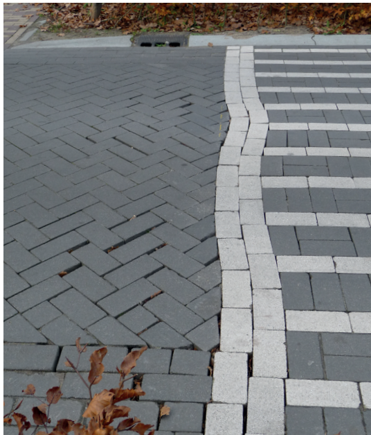
Afb. 6 Haaksheid: twee gevallen van 'niet - haaks' straatwerk. Links: is er sprake van het 'kruipen' van het 'te losse' straatwerk vanwege de verkeersbelasting. Rechts: het straatwerk is 'niet haaks' opgezet. De witte lijn geeft de haakse lijn aan en de rode lijn de afwijking ten opzichte van de haakse lijn.
