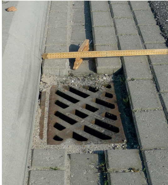
Afb. 9 Klik: twee gevallen van te veel uitgevoerde klik. Links: bij de gootlagen onderling en bij de kolkdeksel. Rechts: bij een controle putdeksel in een parkeervak.
