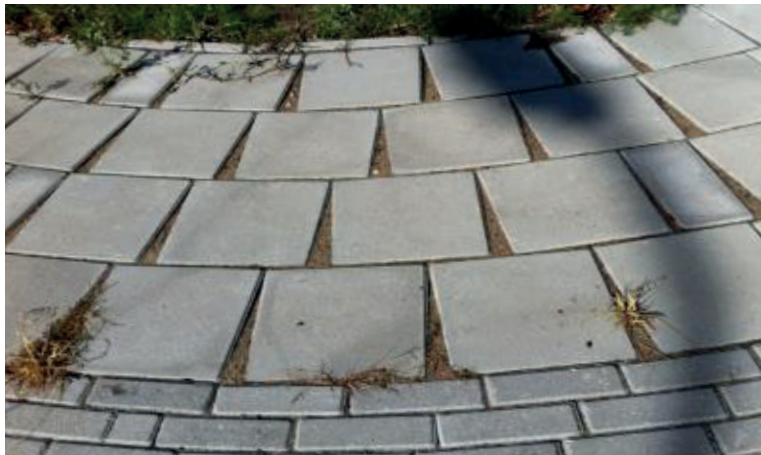
Afb. 11 Voegen: op deze manier ga je met tegelstraatwerk de bocht niet door
