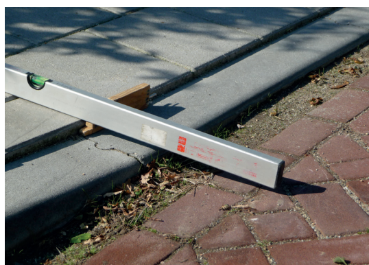
Afb. 8 Klik: twee voorbeelden van te veel uitgevoerde klik. Links: bij trottoirtegels ter plaatse van een verlaagde trottoirband. Rechts: bij een controle putdeksel in de rijbaan, waar ook fietsers rijden.
